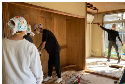
空き家プロジェクト 改修の様子
