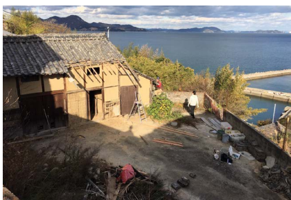
2019年に修繕した屋根が再び崩れたため、2022年に改めて修復している様子。
