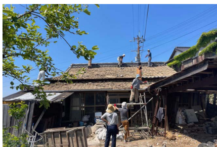
男木島の古民家での瓦屋根修繕 WSの様子
