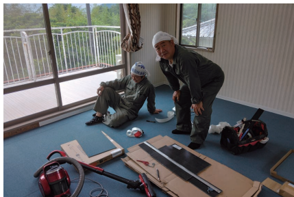
カーペットと巾木の張替作業
