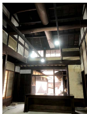
吉本家 吹き抜け空間(竣工後)
