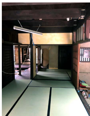
吉本家 居室(竣工後)
