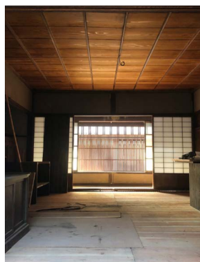
吉本家 工事中写真
